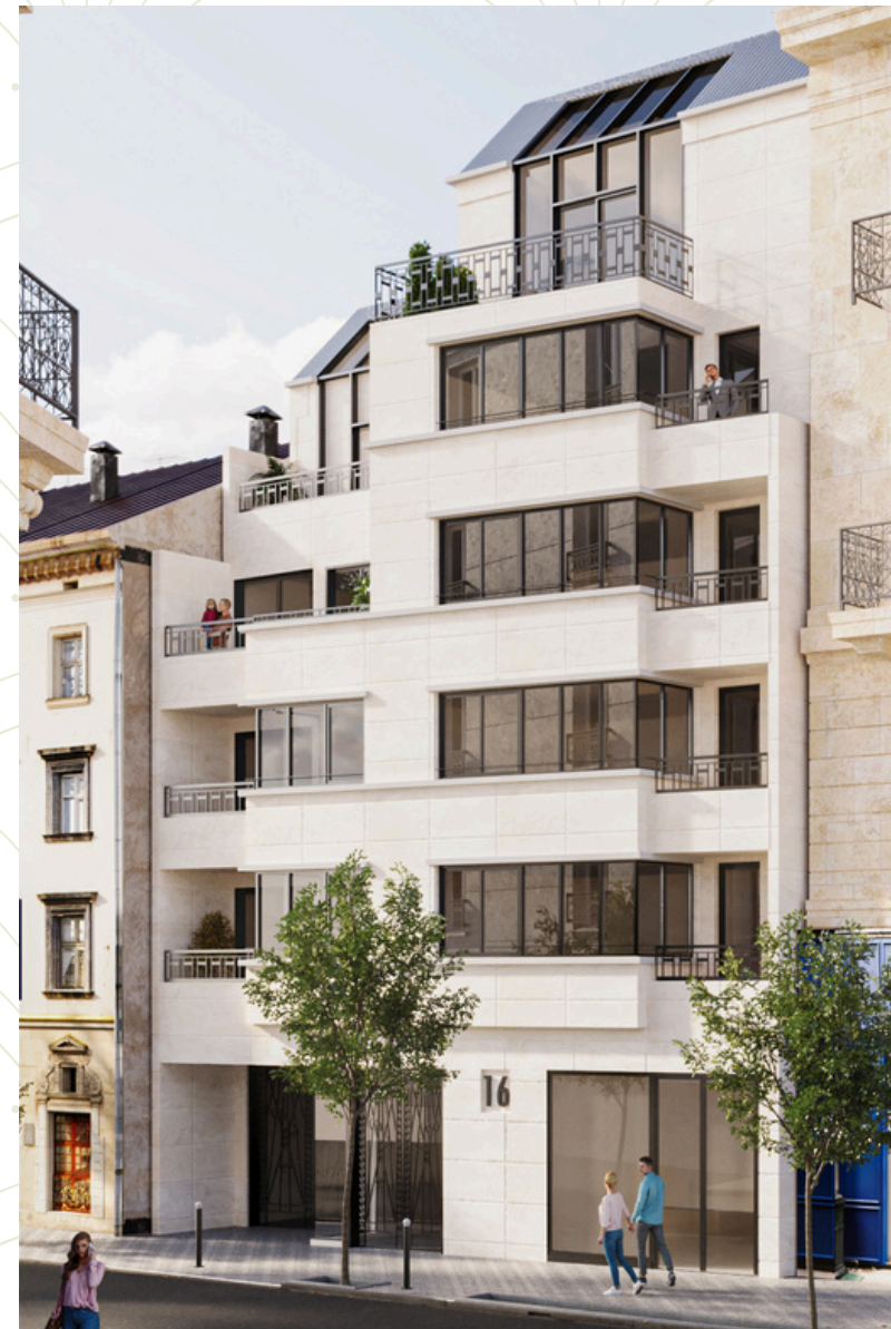
Vue de la façade principale Rue du Général Leclerc 16
